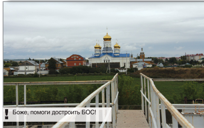
Старые очистные сооружения разваливаются вместе с властью
