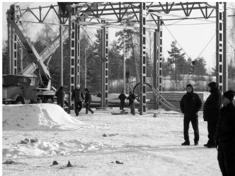
На строящемся полигоне ТБО близ города Дзержинска.
