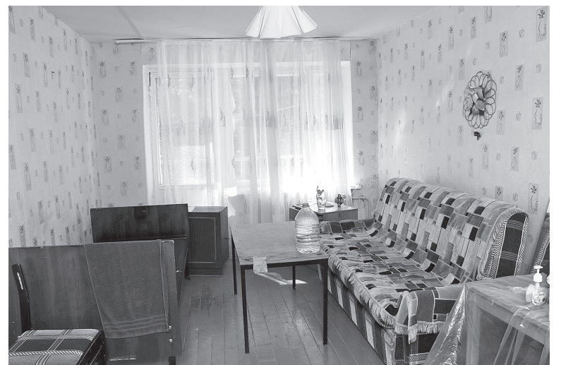
И этот дом хотят признать аварийным?
